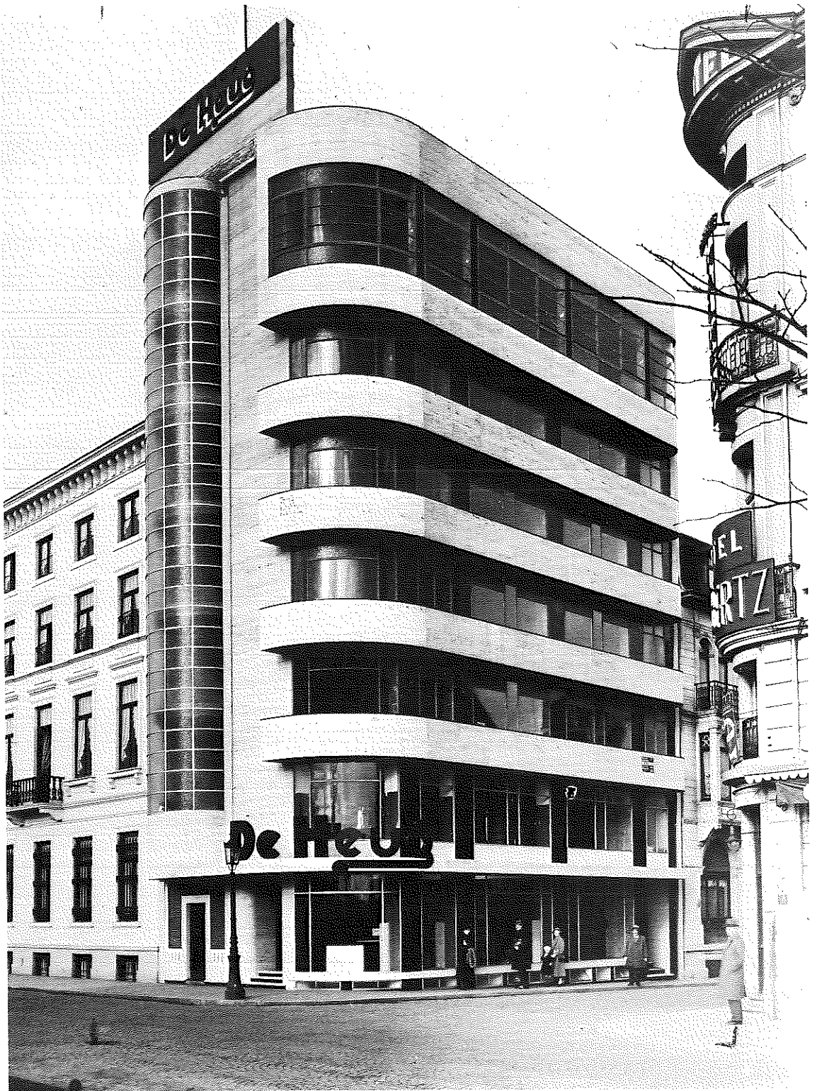
Immeuble commercial et locatif à Charleroi pour la firme de pianos De Heug, 1933. Photographie d'époque.
